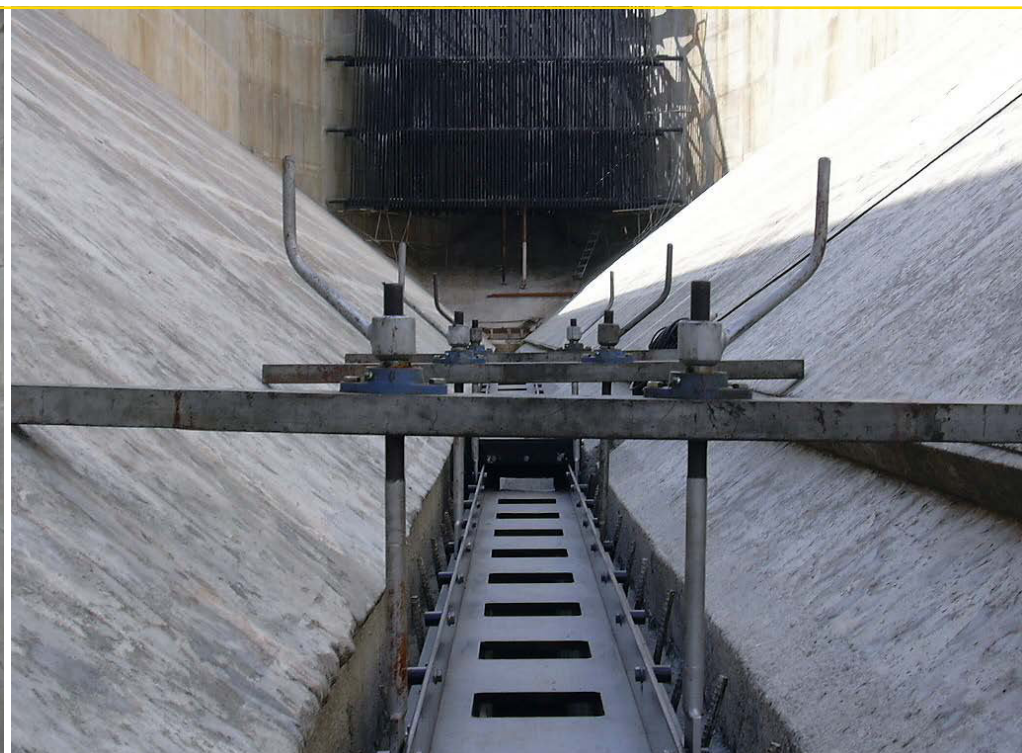
Ausrichten der Basisrahmen
