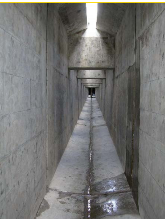
Blick in den Spülwasserkanal
