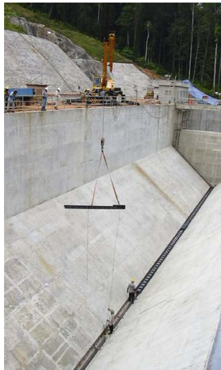
Bau eines offenen Entсандers
